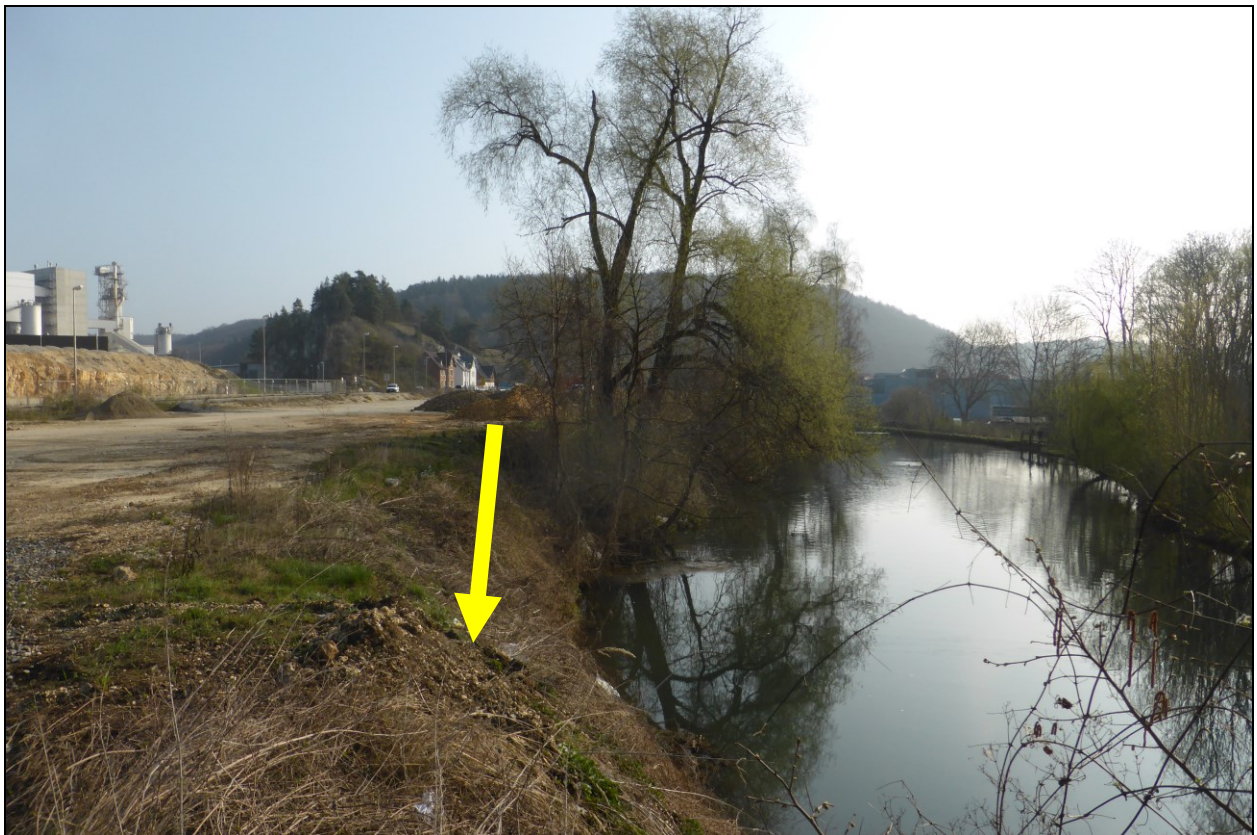
Abb. 6: Anfang Mai 2017 wurden Boden-Mieten aufgeschüttet; im Vordergrund (Pfeil) ist zu erkennen, wie von einer vorigen Miete Material die Böschung hinuntergerutscht ist.
